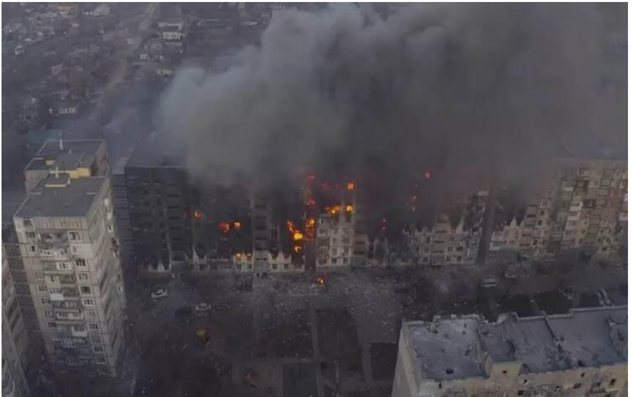
Фото 2. Загальний вид місця пожежі в ході російської агресії (м. Маріуполь) та її наслідки.
